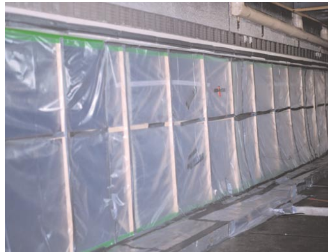
Luftdichte Abschottung - Trennung zwischen Schwarzbereich und Weißbereich.
