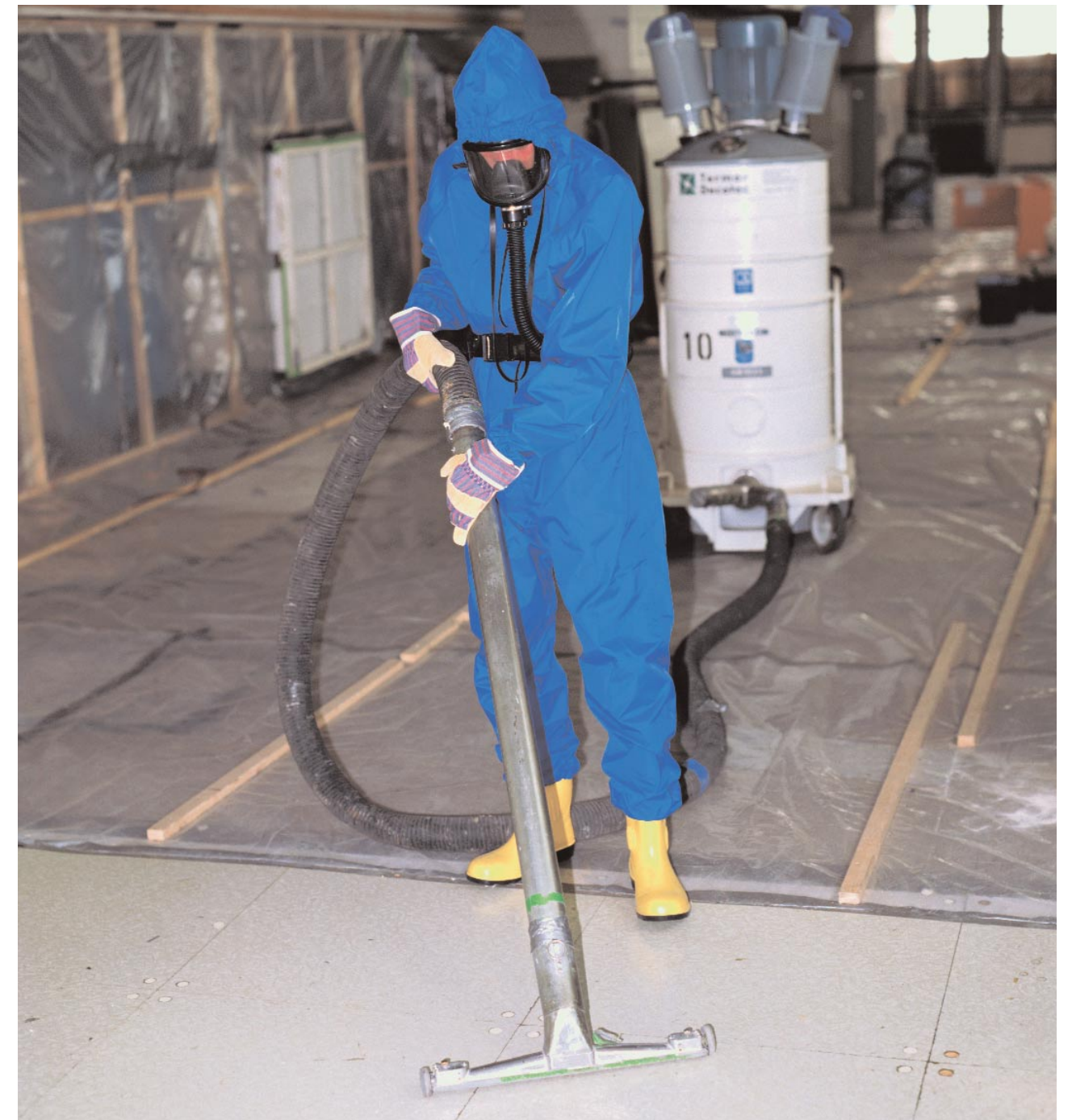
Nach Abschluss der Asbestentsorgung ist eine Feinreinigung aller Flächen im Schwarzbereich vorzunehmen.
