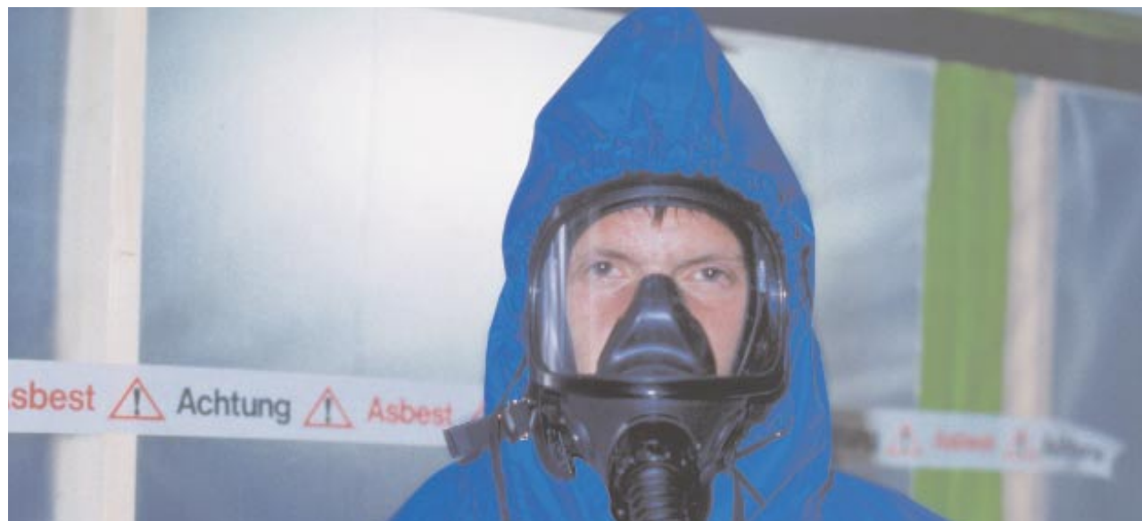
Mitarbeiter mit gebläseunterstütztem Atemschutz vor einer vorschriftsmäßig gekennzeichneten Abschottung.
