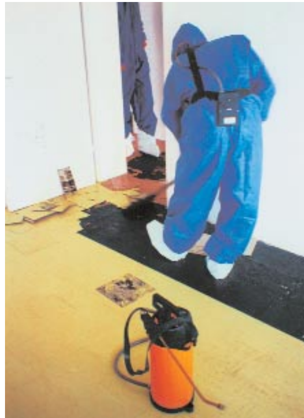
Entfernen von Flexplatten.
